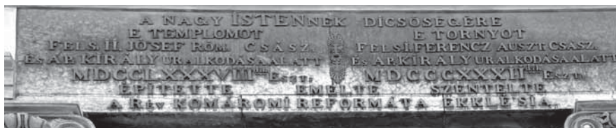
Építési tábla a templom főhomlokzatán
