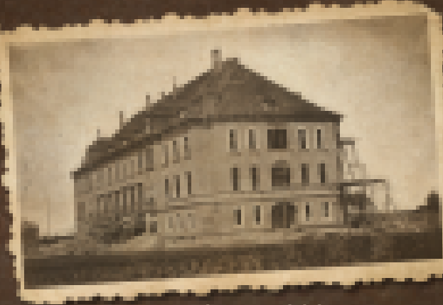
A POLGÁRI ISKOLA ÉPÍTÉSE
