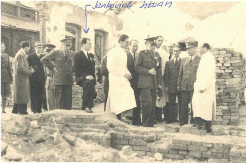
Az Erzsébet Kórház újjáépítési munkálatainak megtekintése 1947-ben
